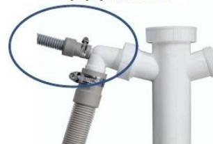
nainstalované připojení k sifonu
